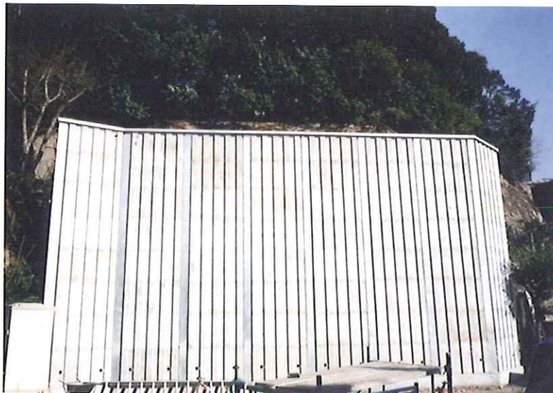
隣地崩壊危険地の防護壁例（壁高8m）
