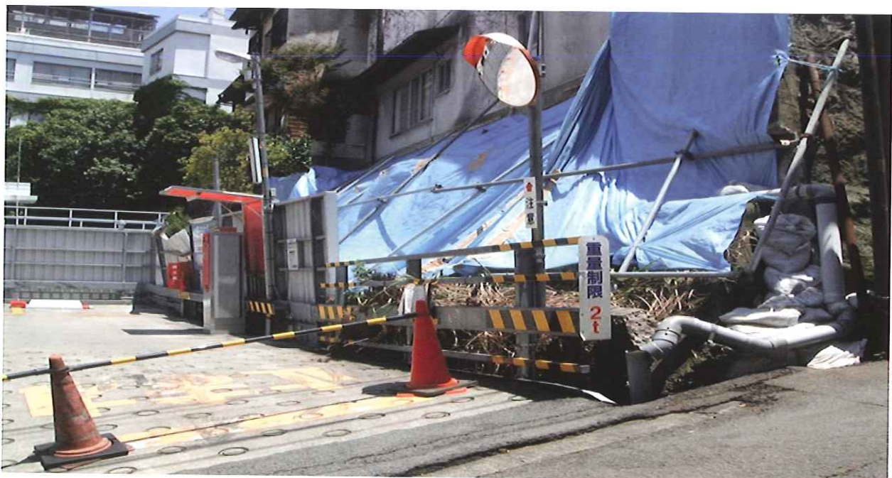
既存崩壊現場復旧工事
