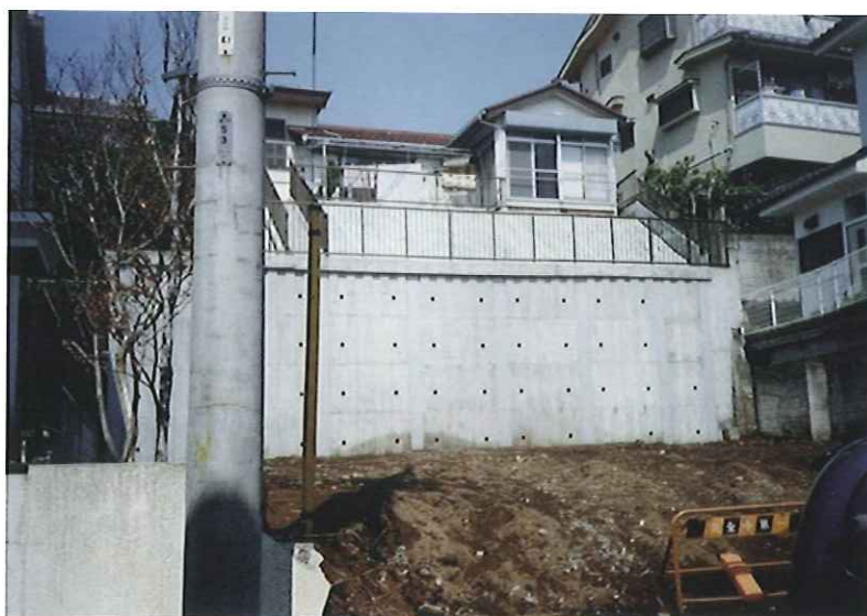
既存危険架台の修復例
