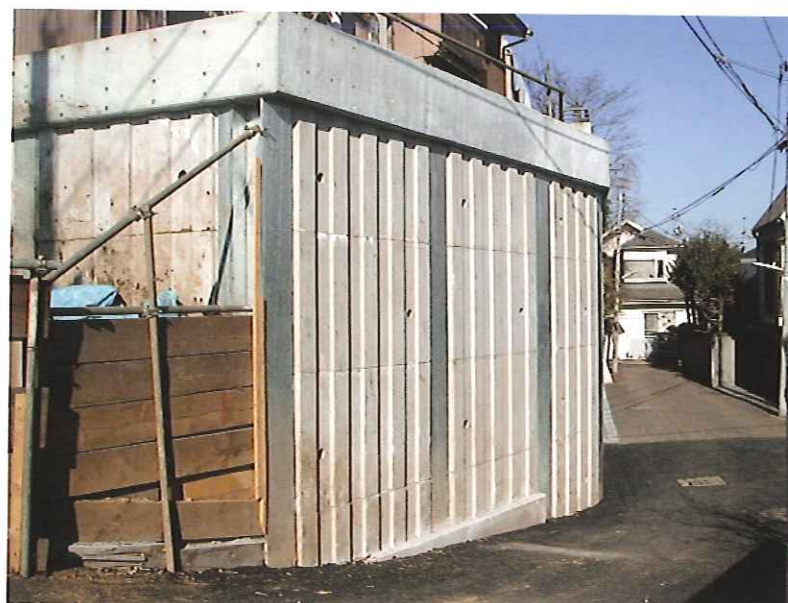
崩壊現場復旧工事
