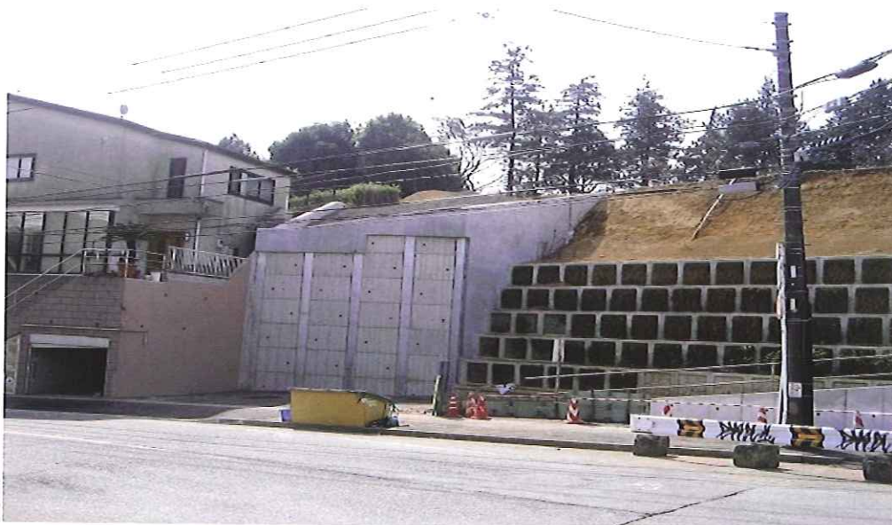
道路整備工事
